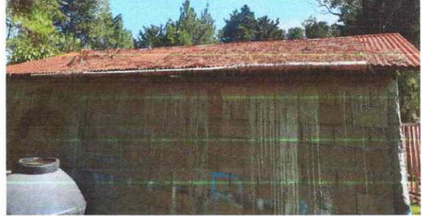
Foto 2: MODULO 2 MANTENIMIENTO (REPELLO Y PINTURA) PARTE TRASERA
