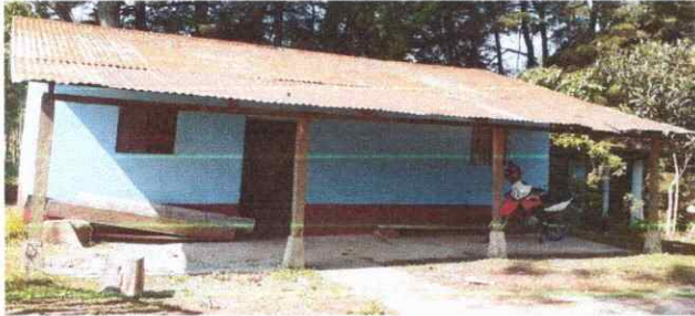
Foto 1: MODULO 2 CAMBIO DE TECHO (LAMINAS Y COSTANERAS) MANTENIMIENTO (PINTURA)
