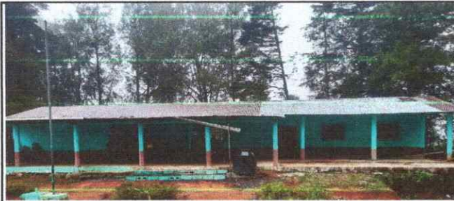
Foto 1: MODULO 1 CAMBIO DE TECHO (LAMINAS Y COSTANERAS)
