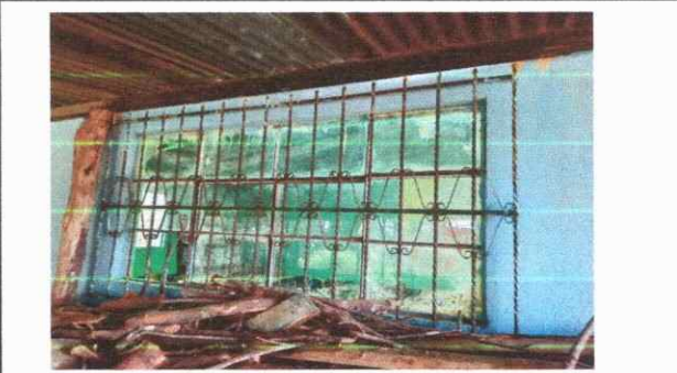
Foto 4: MANTENIMIENTO DE VENTANAS Y BALCONES ( MODULO 1 PARTE LATERAL)
