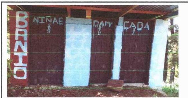
Foto 5: MANTENIMIENTO DE BAÑOS, PINTURA Y CAMBIO DE PUERTA DE MADERA A PUERTA METALICA
