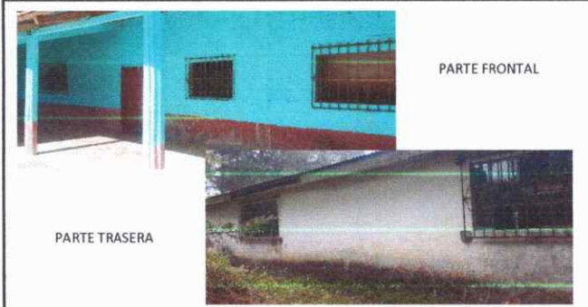
Foto 3: MANTENIMIENTO DE VENTANAS Y BALCONES (PARTE FRONTAL MODULO 1) , COLOCACION DE VIDRIOS
