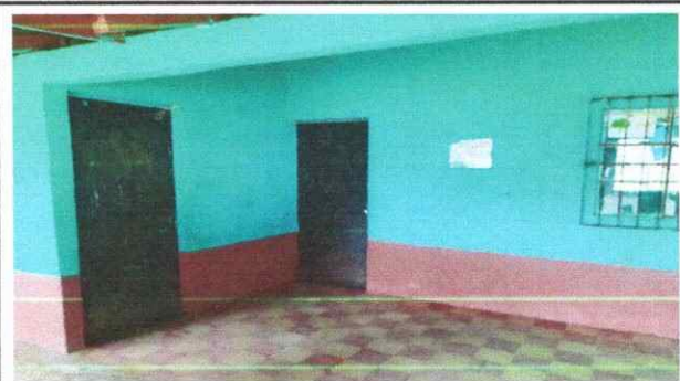
Foto 2: MANTENIMIENTO DE PUERTAS (CAMBIO DE CHAPA, LIJADO Y PINTURA)
